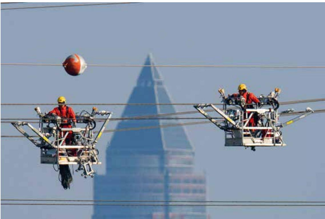
*In luftiger Höhe warten Techniker die Stromleitungen an Hochspannungsmasten an der A5 bei Frankfurt am Main. Sie fahren mit Montageschlitten vor der Skyline entlang.*
